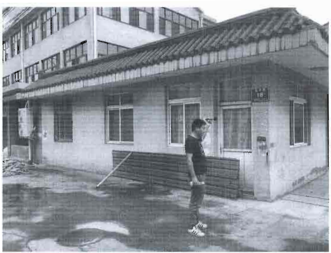
厂界噪声现场采样照片
